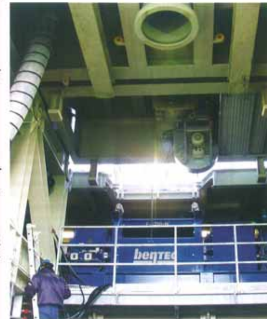
Montage einer Bohranlage des Typs HR 4500 der Firma Bentec
